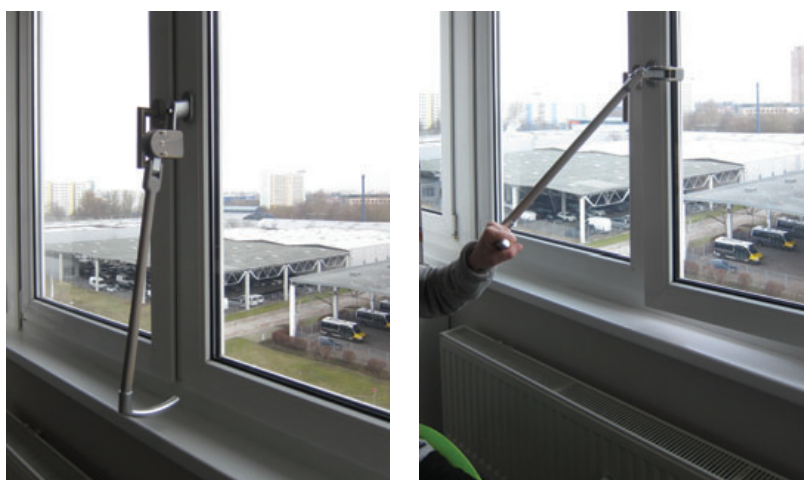
101 – 102 Können barrierefreie Bedienhöhen nicht realisiert werden, unterstützen Greif-/Adaptionshilfen das Öffnen der Fenster; Musterwohnung, Berlin www.ermuendigung.de
