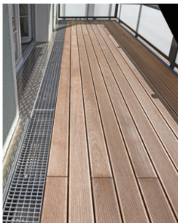
107 – 108 Vorgestellte Balkone mit Aufzugsanlage an einem denkmalgeschützten Gebäude; Hohenzollernhöfe, Ludwigshafen
