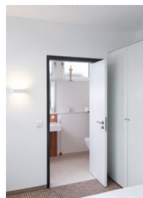
86 – 89 Mit Raumpartüren können Bewegungsflächen für Rollstuhlfahrerinnen und -fahrer sowie Nutzerinnen und Nutzer von Rollatoren minimiert werden. Eine frontale Durchfahrt ist von beiden Seiten möglich.
