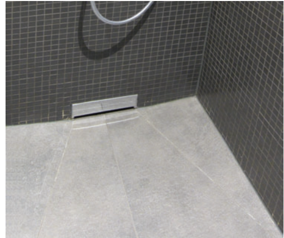
141 – 142 Duschplatzgestaltung mit vorgefertigten Duschelementen bzw. Entwässerung über alternative Wandeinläufe
