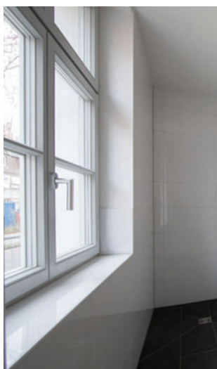
98 – 99 Nach der denkmalgerechten Sanierung sind die Fensterflügel auch aus sitzender Position (max. Höhe 120 cm) bedienbar; Hohenzollernhöfe, Ludwigshafen
