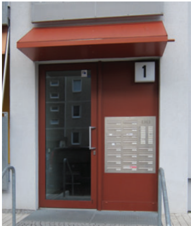
55 Ausgemittelte Bedienhöhen Klingelanlage und Briefkästen; Gartenstadt Drewitz, ProPotsdam
