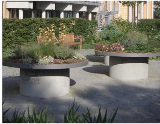
40 – 41 Das unterfahrbare Hochbeet besteht aus einem handelsüblichen Beton-schachtring mit einer darauf liegenden Stahlplatte. Eine 12 cm hohe Aufkantung hält die Pflanzenerde.
