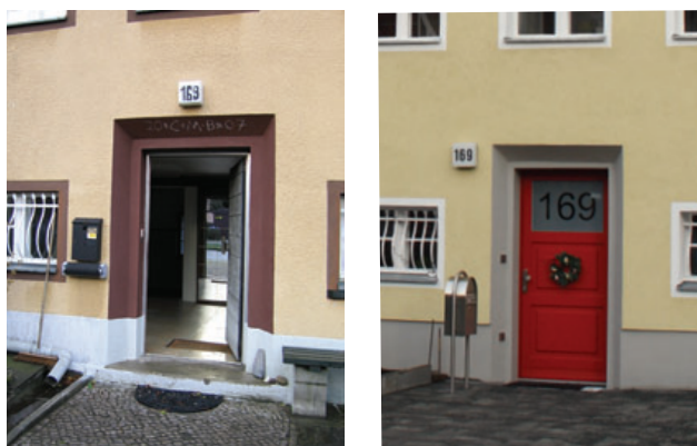
46 – 47 Rückbau Stufe und niveaugleiche Ausbildung der Hauseingangstür; Umbau Pfarrhaus, Berlin
