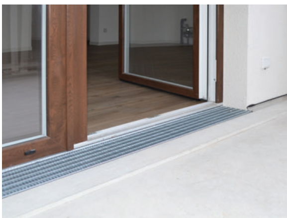
111 Schwellenhöhen bis 2 cm sind zulässig, wenn sie baukonstruktiv erforderlich sind; Kanadaring, Lahr
