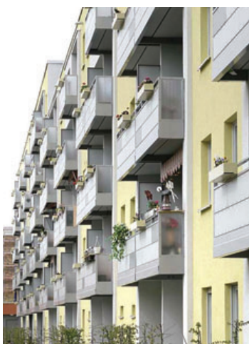
104 – 106 Im Zuge der energetischen Sanierung kann durch Loggiaverlängerungen die nutzbare Tiefe des Freisitzes erhöht werden; Ostseevierviertel Parkseite, WVG Greifswald
