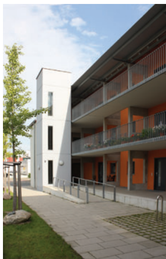
25 Rampe und Aufzug sichern die stufenlose Erreichbarkeit aller Wohnungen; Modellprojekt „WAL“, WBG Nürnberg
