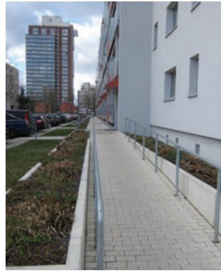
32 – 33 Über an den Ecken angelegte Rampen sind mehrere Hauseingänge stufenlos erreichbar; Gartenstadt Drewitz, ProPotsdam
