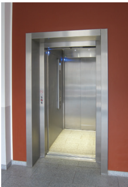
79 – 81 Stufenlose Erreichbarkeit der Wohnungen durch Einbau eines Aufzugs als Durchlader, Gartenstadt Drewitz, ProPotsdam
