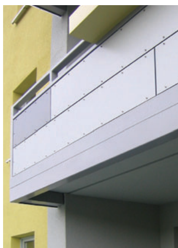
104 – 106 Im Zuge der energetischen Sanierung kann durch Loggiaverlängerungen die nutzbare Tiefe des Freisitzes erhöht werden; Ostseevierviertel Parkseite, WVG Greifswald
