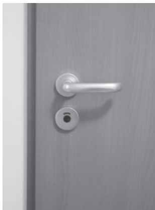
131 – 132 Von außen entriegelbarer Türbeschlag ermöglicht den Zutritt zum Bad bzw. Sanitärraum im Notfall; Paul Gerhard Stift, Berlin
