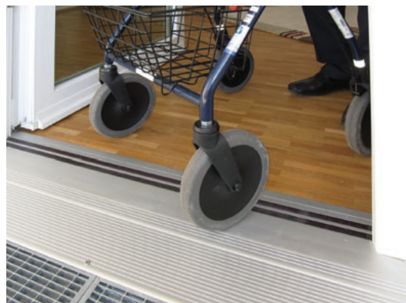
110 Niveaugleiche Magnet-Türdichtungen leiten anfallendes Wasser über die Konstruktion nach außen ab.
