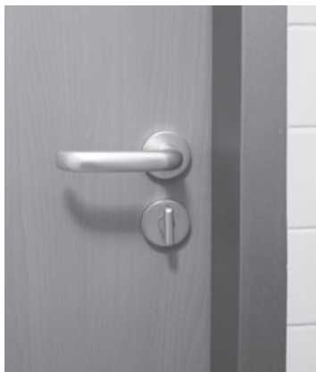
131 – 132 Von außen entriegelbarer Türbeschlag ermöglicht den Zutritt zum Bad bzw. Sanitärraum im Notfall; Paul Gerhard Stift, Berlin
