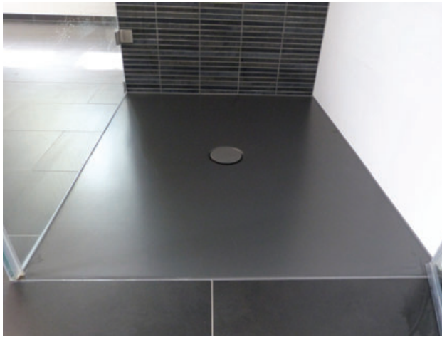
141 – 142 Duschplatzgestaltung mit vorgefertigten Duschelementen bzw. Entwässerung über alternative Wandeinläufe
