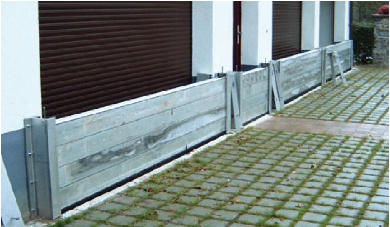
Abbildung: Mobiler Objektschutz vor Garageneinfahrten (Dammbalken)
