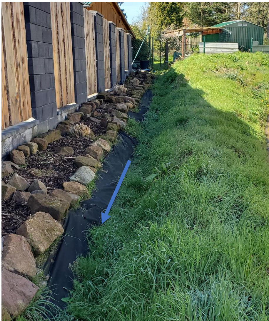
Abbildung: Graben zwischen Nikolauskirche und Nachbargrundstück
