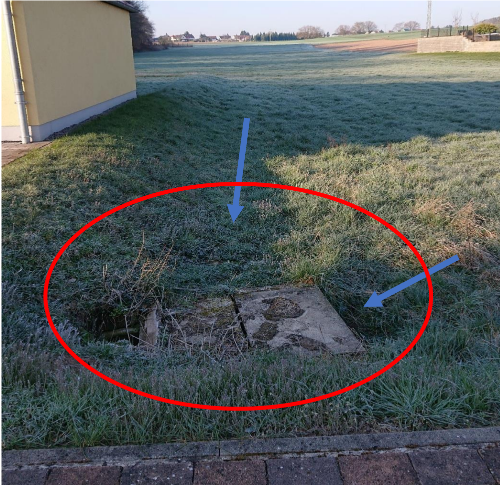
Abbildung: Vorh. Einlaufbauwerk „Im Weiher“
