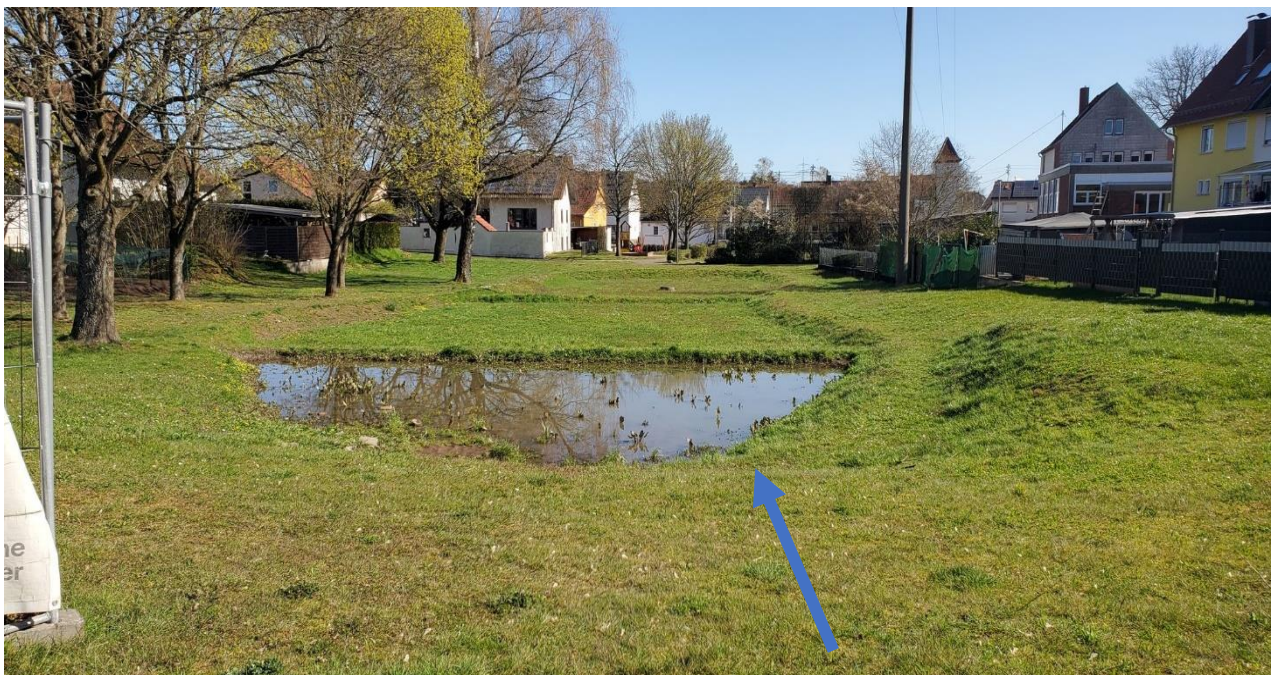
Abbildung: Vorh. Rückhaltebecken als Notabflussweg ausweisen
