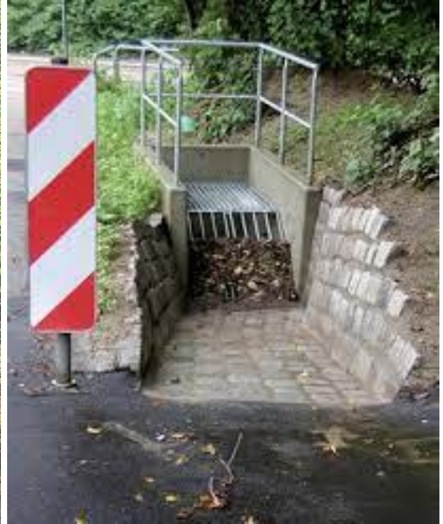
Beispiel: Geschützter Rohreinlauf mit überströmbarrem Rechen
