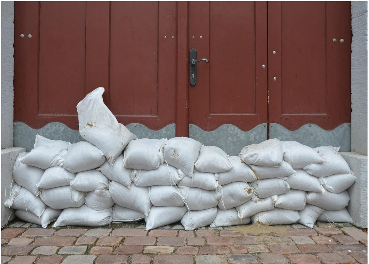
Abbildung: Sandsäcke vor Eingangsbereich
