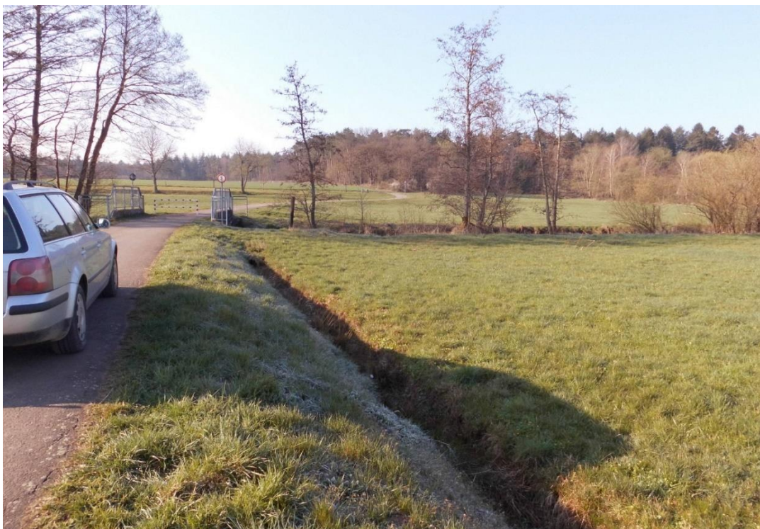
Abbildung: Kohlbachbrücke „Im Espenferch“
