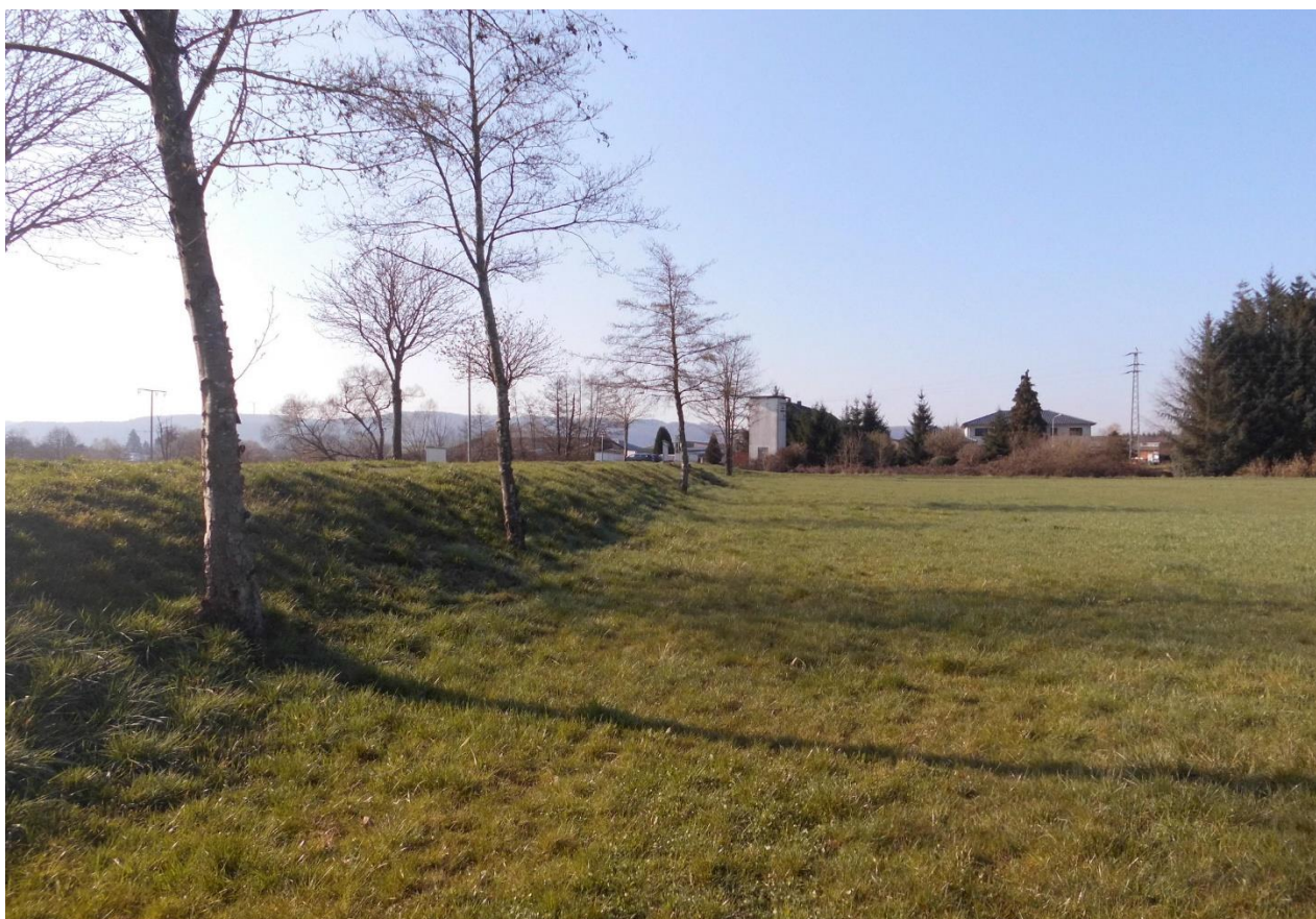
Abbildung: Dammb der Mühlstraße
