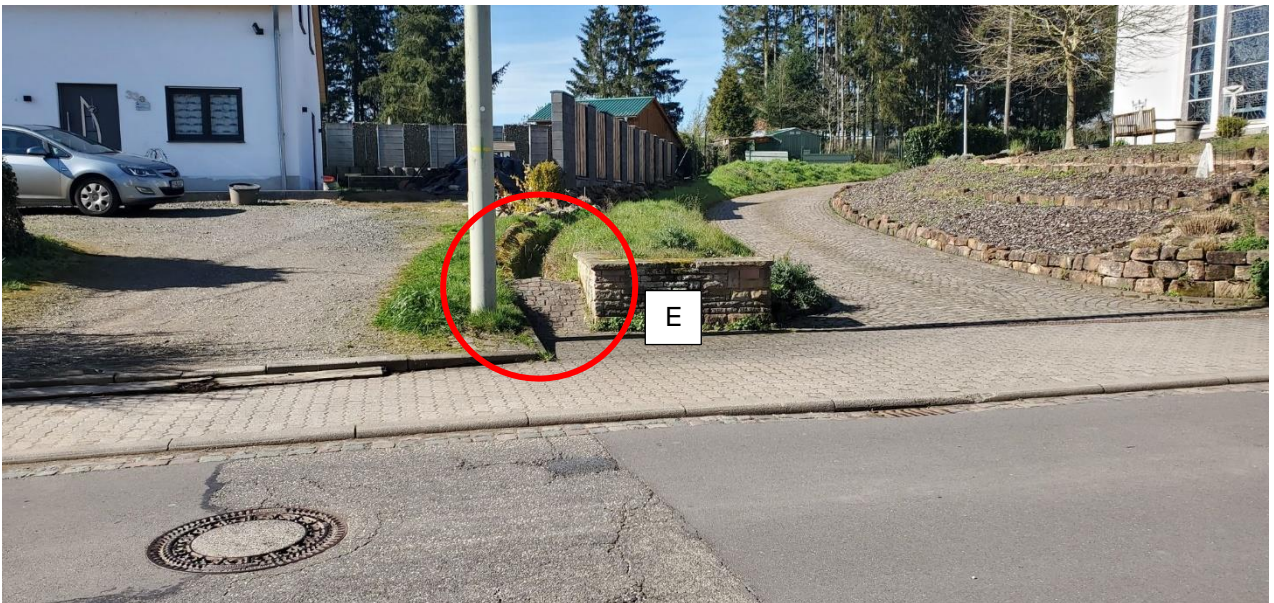
Abbildung: Vorh. Einlaufbereich an der Nikolauskirche
