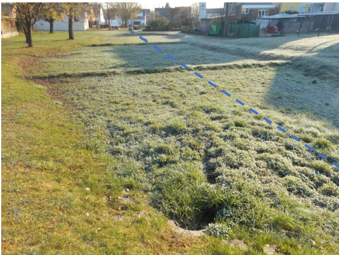
Abbildung: Rückhaltemaßnahme „Im Weiher“ mit Verrohrung
