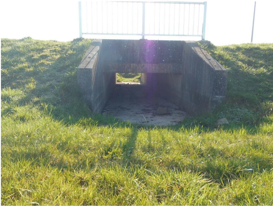
Abbildung: Durchlassbauwerk im Damm der Mühlstraße
