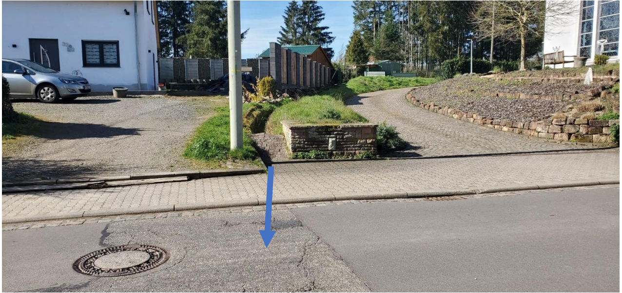
Abbildung: Graben zwischen Nikolauskirche und Nachbargrundstück
